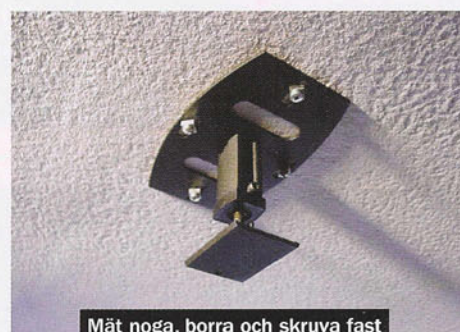
Mät noga, borra och skruva fast takfästet i de fyra hålen.
