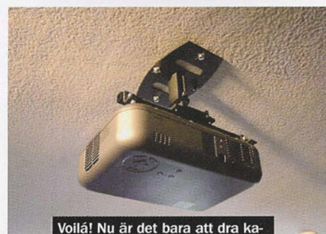
Voilà! Nu är det bara att dra kablarna snyggt så är allting klart!
